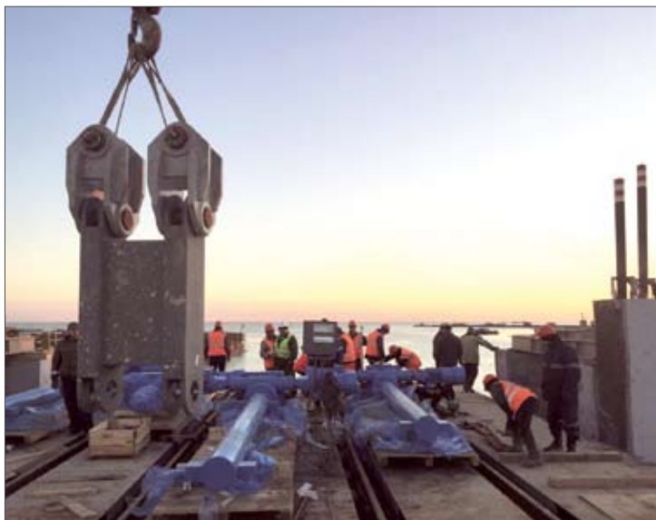
На строительстве подъемно-переходных мостов, порт Курык
