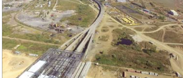
Вид на строящуюся стрелочную улицу. Железнодорожная эстакада, г. Астана
