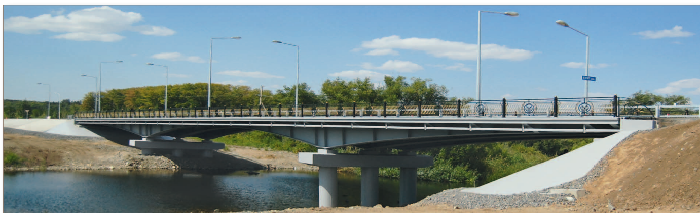
• Металлический цельносварной автодорожный мост у села Куйгенжар (Акмолинская область, Республика Казахстан)
