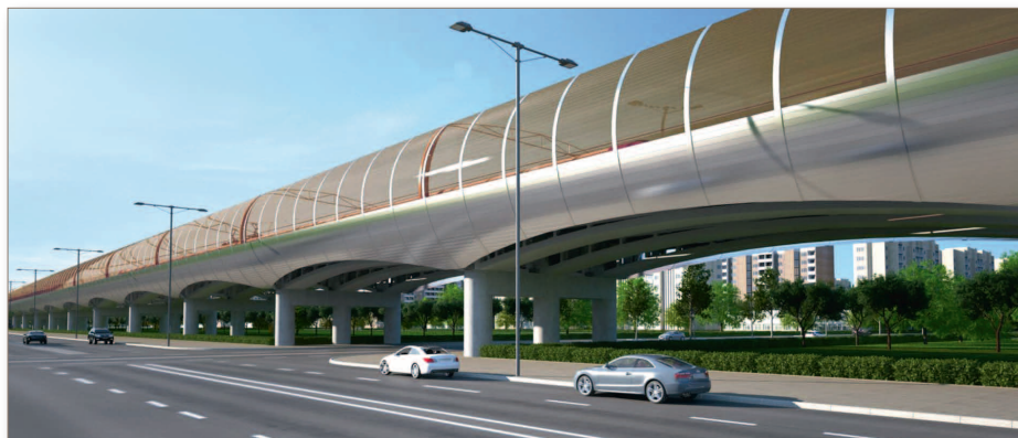
• Эстакада к новому железнодорожному вокзалу в городе Астана (Республика Казахстан)
