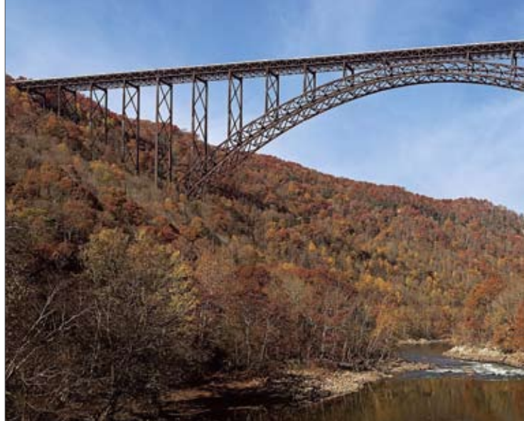
Мост New River Gorge Bridge в Западной Вирджинии
