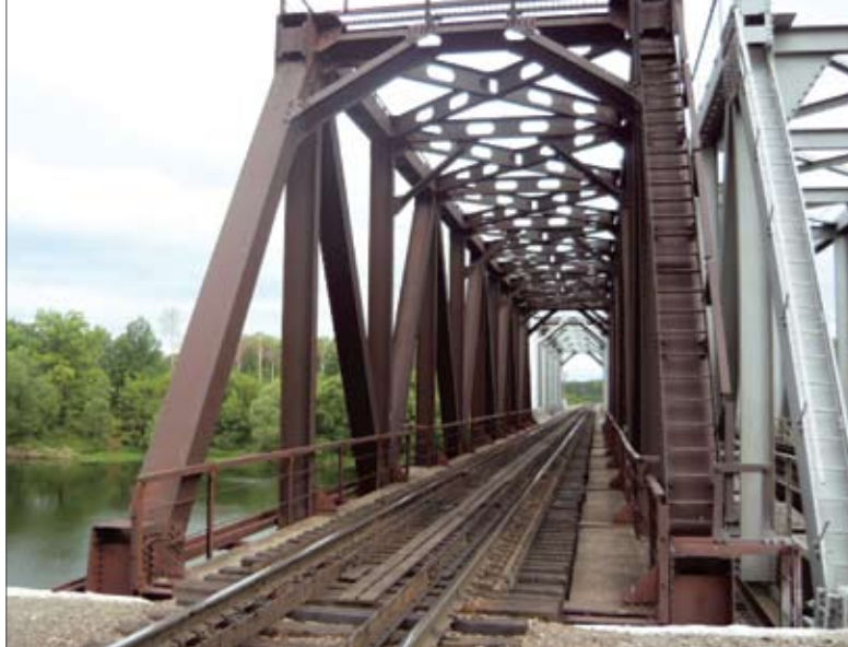
Мост через реку Ворона ЮВЖД
